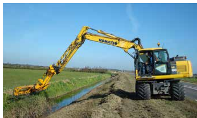
Escavatore con benna falciante e braccio di prolunga per raggiungere maggiori raggi operativi..
