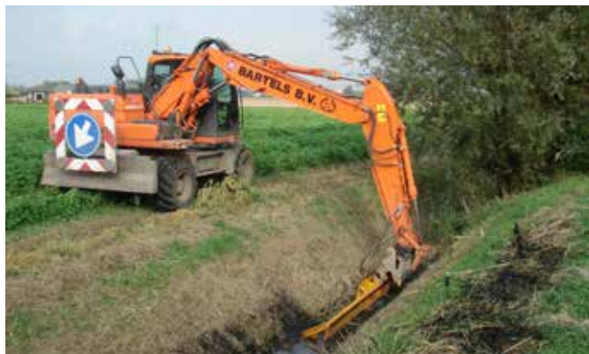
Łyżka Herdera zamontowana na ramieniu koparki.
